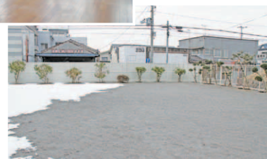
整備中の屋外園庭
